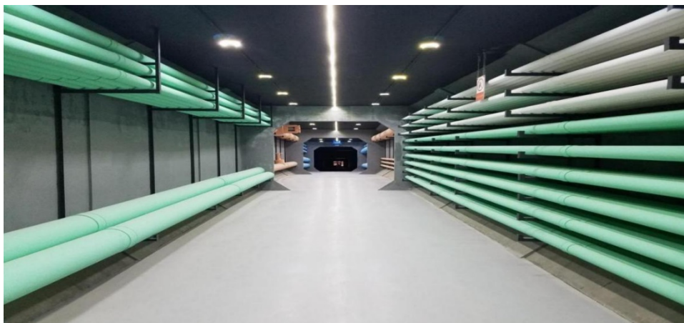
地下综合管廊与地上应急救援中心连接通道
