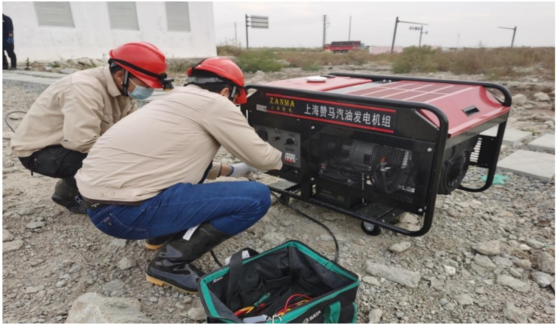
发电机接线保障抢险用电
