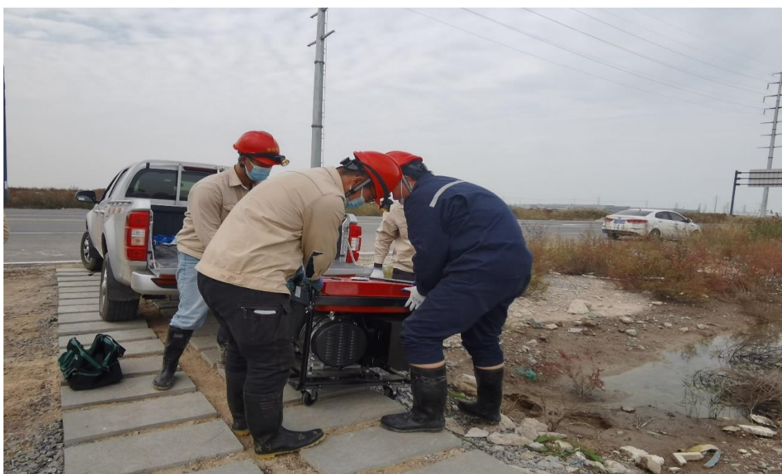
搬运发电机等供电设备
